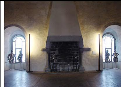
Die offene, in der Mitte eines Raumes liegende, Feuerstelle wurde ab dem 8. Jahrhundert durch gemauerte Kamine ersetzt. Dies bot einerseits eine höhere Brandsicherheit und andererseits konnten die Kaminsteine die Wärme etwas speichern. Allerdings ging noch immer ein Grossteil der Wärme verloren, da der warme Rauch über einen Rauchfang und Schornstein direkt nach draussen geleitet wurde.
