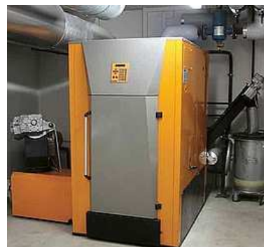
Pelletheizung (Zentralheizung)
